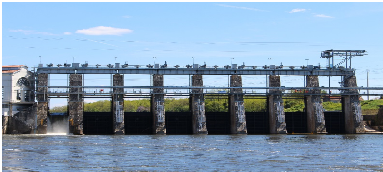
Barrage de Tuilières
